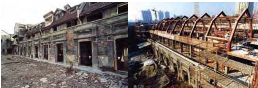
圖 7.4. 整齊排列的石庫門原貌及石庫門翻新工程添加的新式屋頂結構
